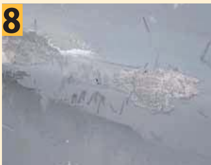
Предварительная обработка наждачной шкуркой зернистостью от 40 до 60
