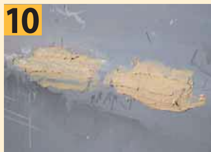
Наносим первый слой универсальной шпатлевки
