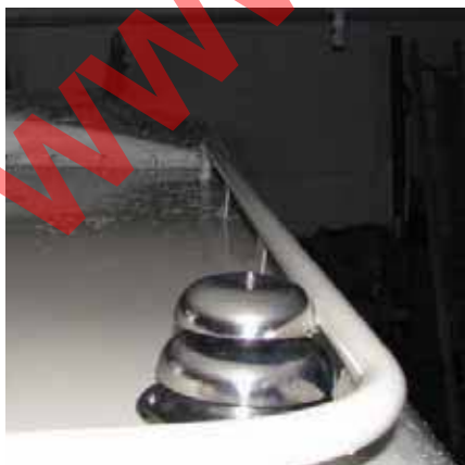
Рис. 6. Коаксиальный дымоход отопителя «Dickinson Newport» на хардтопе каюта
