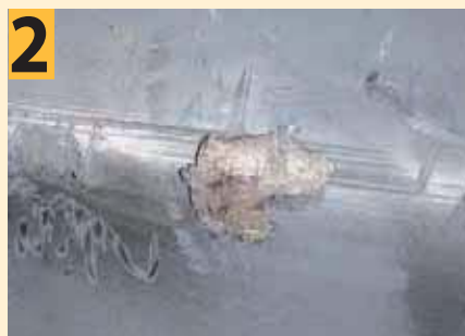
Убираем все отложения, отслаивающееся декоративное покрытие и обрабатываем данное место обезжиривающим веществом (в нашем случае – ацетоном)
