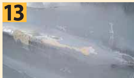
Доводим наждачной шкуркой ремонтируемый участок до «кондиции»
